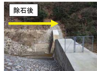
砂防堰堤の除石事例
