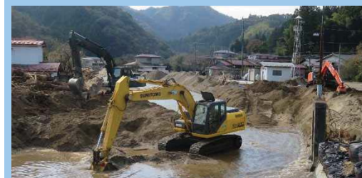
10月30日(発災から18日後)、河道埋塞土の撤去に着手
